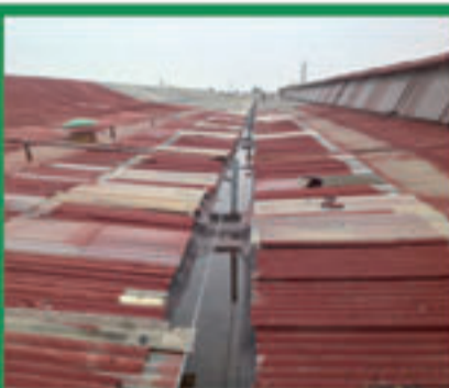
Rimozione Amianto
